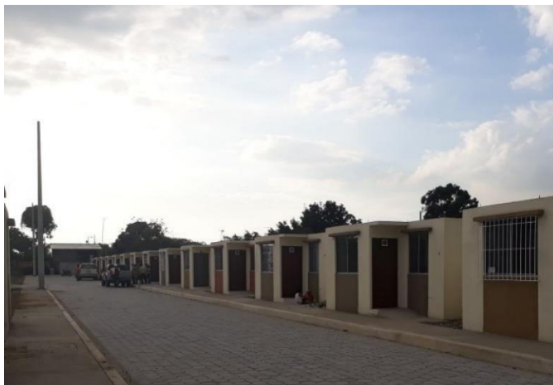
Fotografía 1: Viviendas Club de Leones.
