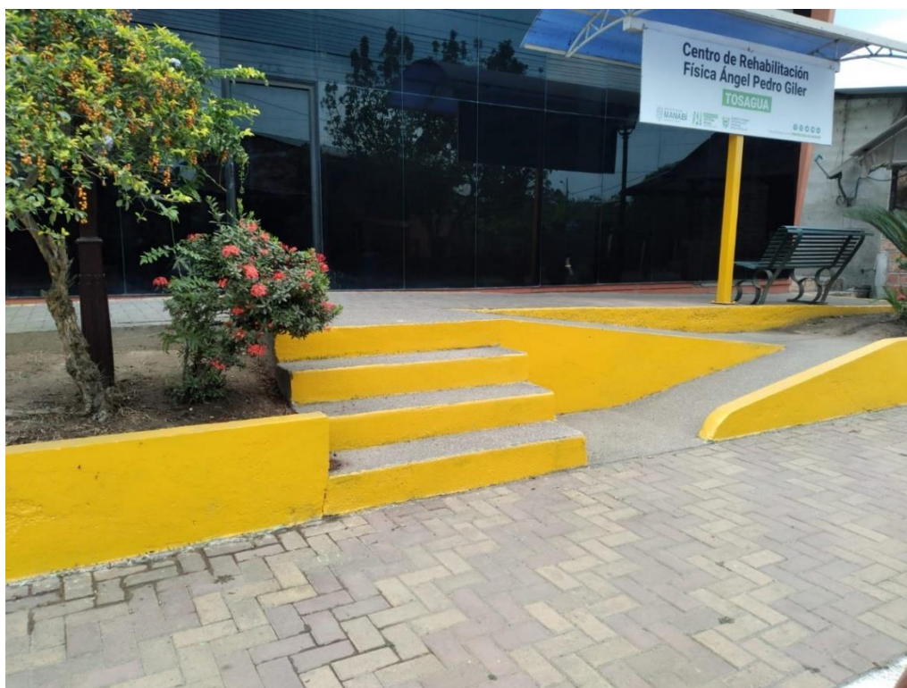
Pintado de los exteriores del centro diurno
